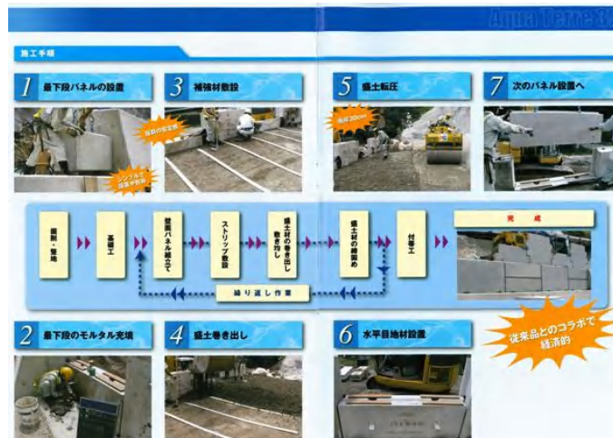
アクアテール35 施工手順
