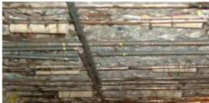
ガルバシールドCC135設置状況(断面修復部への適用)
