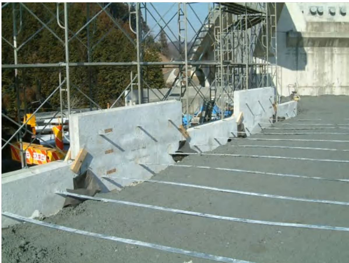
写真4 ストリップの設置
