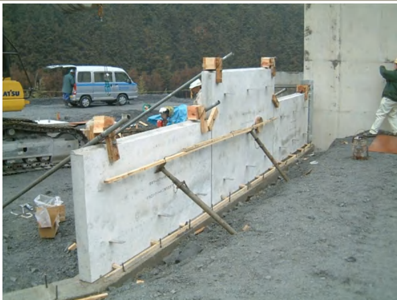
写真-3 コンクリートパネル設置状況
