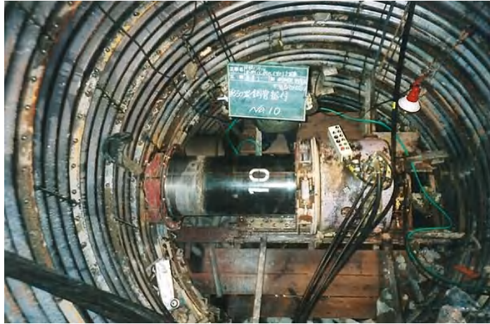
CCBOX工事 削進状況
