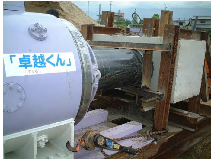
第3回すぐる君実験施工写真
