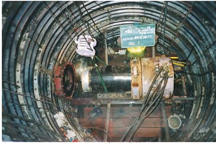
CCBOX工事 発進状況
